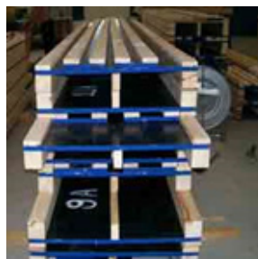
Figura 50 - Armazenamento de Fôrmas Prontas
