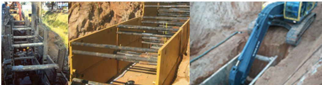
Figura 106 - Escoramento de Taludes
