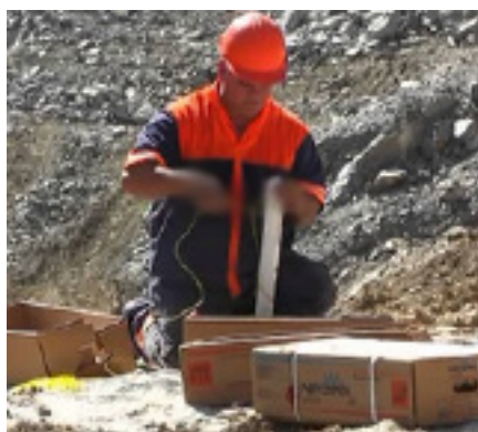
Figura 104 - Desmonte de Rocha a Fogo
