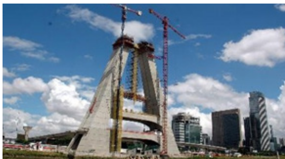
Figura 181 - Forma Trepante
