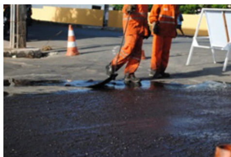
Figura 135 - Pintura de Ligação
