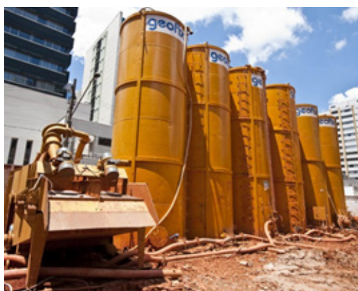
Figura 207 - Preparação de Lama Bentonítica
