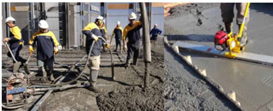
Figura 191 - Vibração do Concreto com Vibrador
