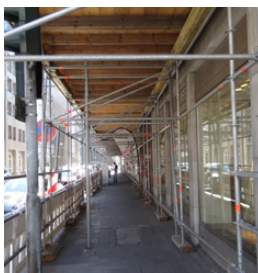
Figura 91 - Galeria de Proteção do Público
