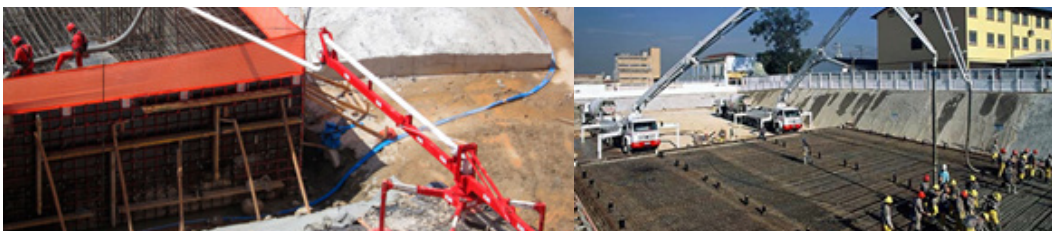
Figura 185 - Concretagem
