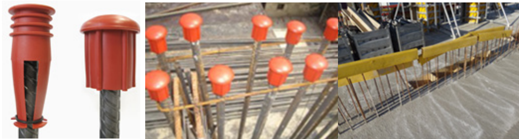
Figura 156 - Proteções de Pontas de Vergalhões
