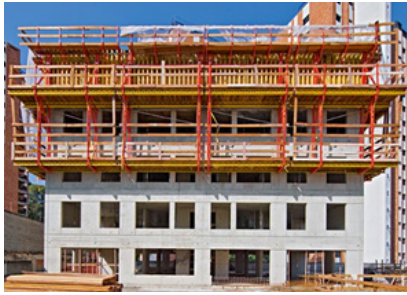
Figura 164 - Fôrma Trepante
