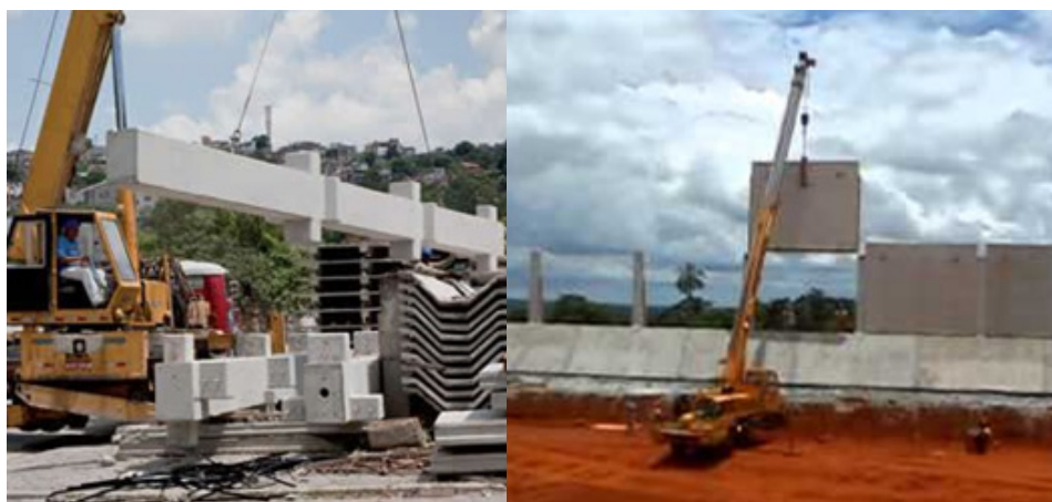
Figura 200 - Içamento de Peças Pré-fabricadas
