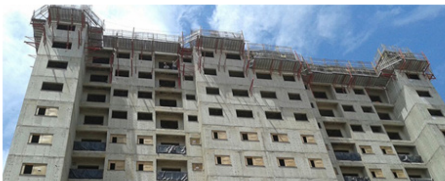
Figura 203 - Paredes de Concreto
