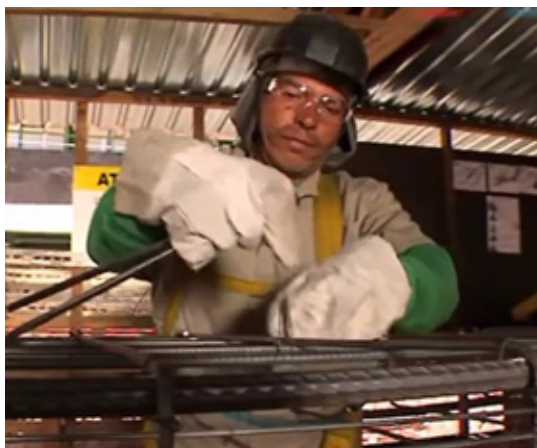
Figura 152 - Equipamentos de Proteção para Montagem de Armadura
