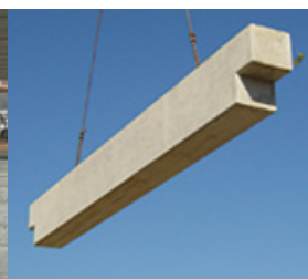
Figura 197 - Viga Retangular
