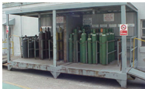
Figura 53 - Armazenamento de Cilindros
