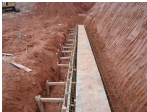
Figura 206 - Construção de Mureta Guia
