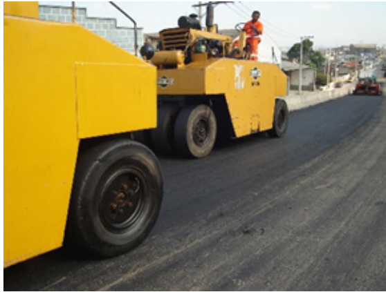
Figura 130 - Obras de Pavimentação
