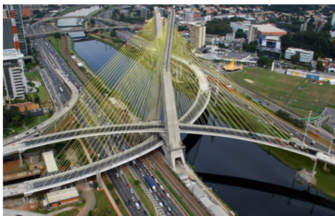
Figura 216 - Ponte Estaiada Octavio Frias de Oliveira – SP
