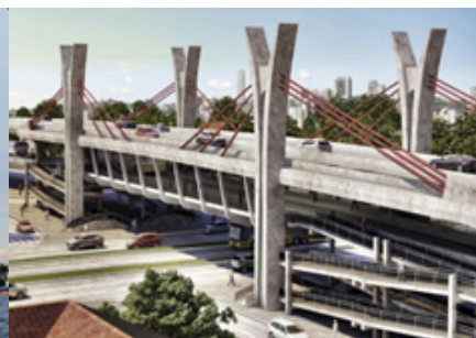
Figura 214 - Construção de Viaduto
