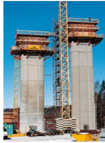
Figura 165 - Forma Deslizante Vertical
