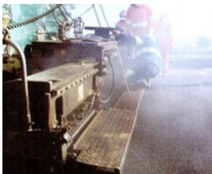
Figura 131 - Emissões de Fumos do Asfalto
