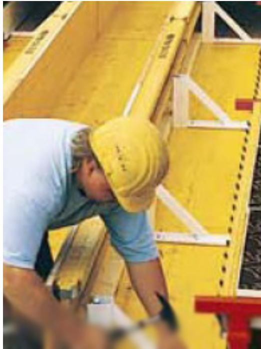
Figura 178 - Fôrmas para Vigas
