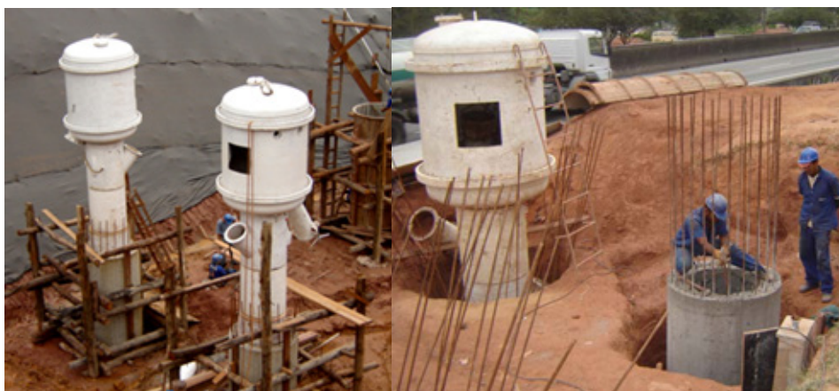
Figura 110 - Campânula para Execução de Tubulão com Ar Comprimido
