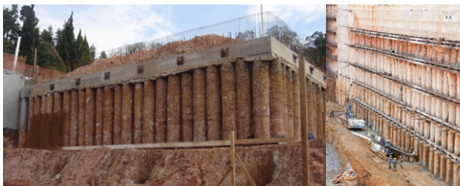
Figura 212- Estacas Atirantadas
