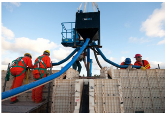
Figura 189 - Concretagem com Caçamba de Concreto
