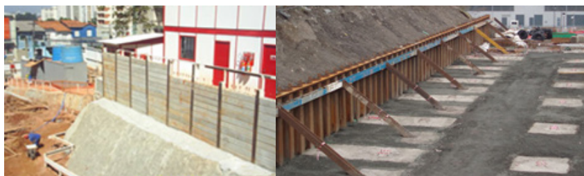
Figura 107 - Estabilização de Taludes
