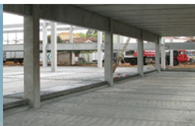
Figura 196 - Painéis de Lajes Protendidas
