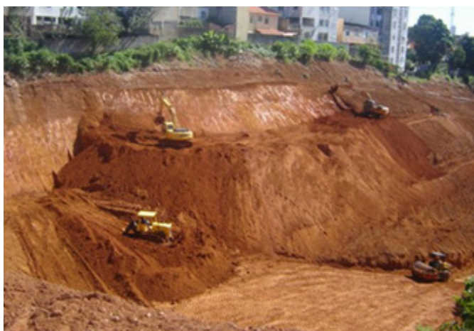
Figura 101 - Movimentação de Terra - Corte
