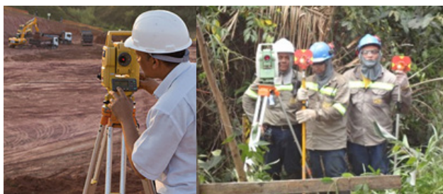
Figura 125 - Serviços de Topografia
