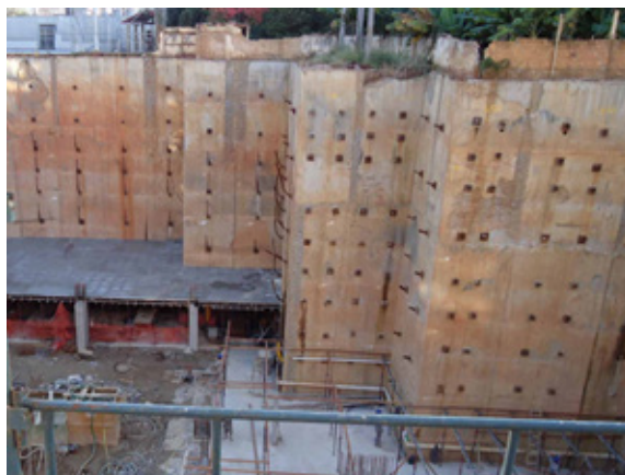
Figura 204 - Parede Diafragma
