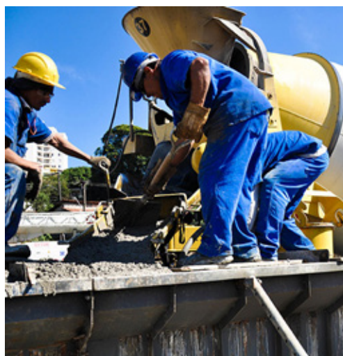
Figura 188 - Concretagem com Caminhão Betoneira
