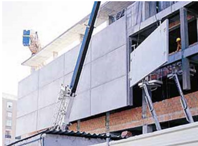
Figura 201 - Montagem de Elementos Pré-fabricados
