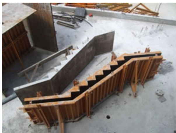
Figura 180 - Fôrma Metálica Pré-fabricada
