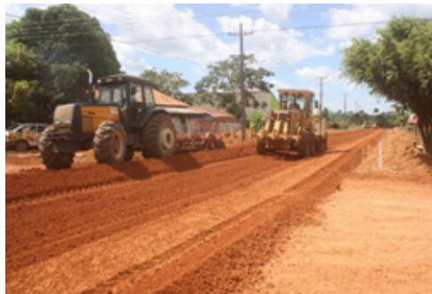
Figura 116 - Obras de Terraplenagem
