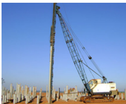
Figura 114 - Bate-estacas (Concreto)
