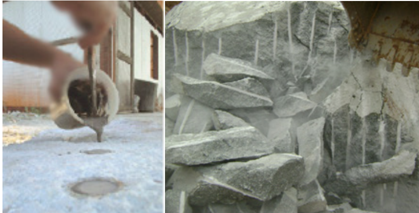
Figura 98 - Exemplo de Demolição por Expansão
