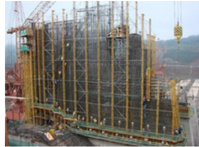
Figura 166 - Fôrma Deslizante Horizontal
