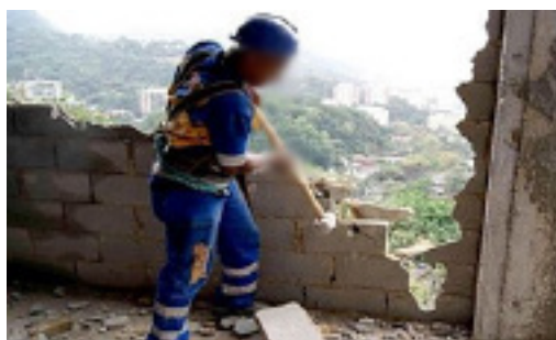
Figura 93 - Demolição Manual
