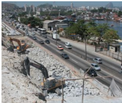
Figura 102 - Desmonte de Rocha com Explosivos e Máquinas
