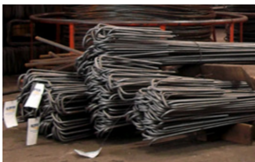
Figura 158 - Armazenamento de Aço Cortado e Dobrado
