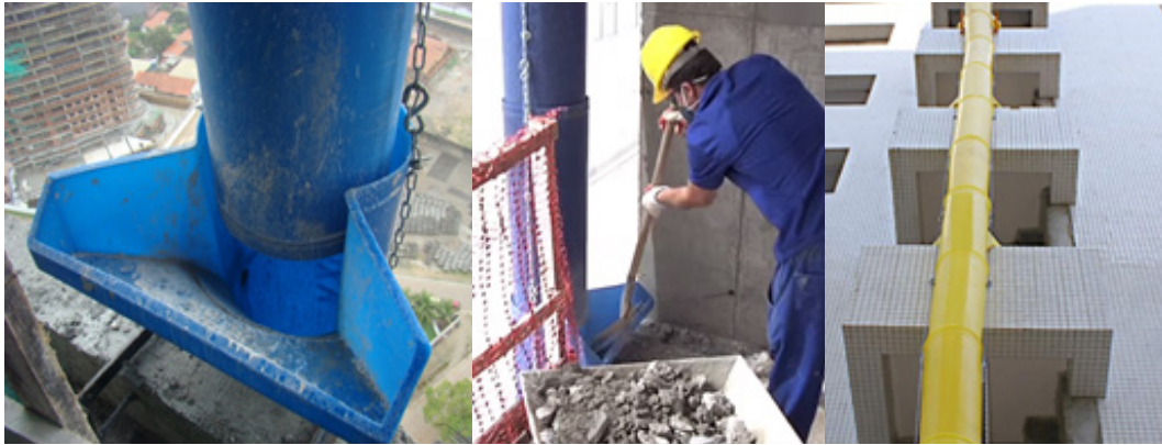
Figura 89 - Calhas ou Dutos para Retirada de Material de Demolição
