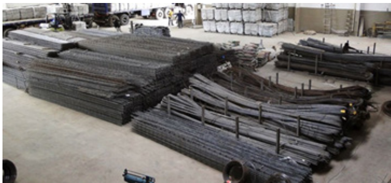
Figura 47 - Armazenamento de Barras de Aço
