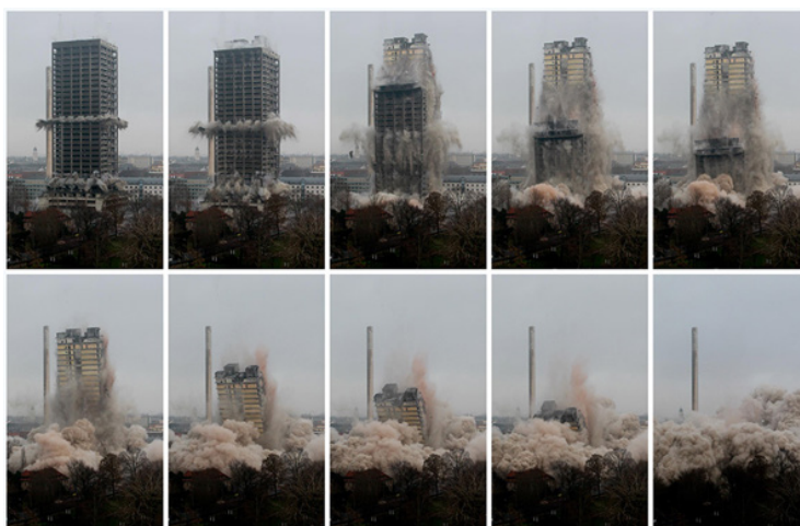
Figura 99 - Sequência da Implosão de um Edifício
