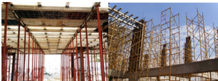
Figura 159 - Cimbramento Metálico
