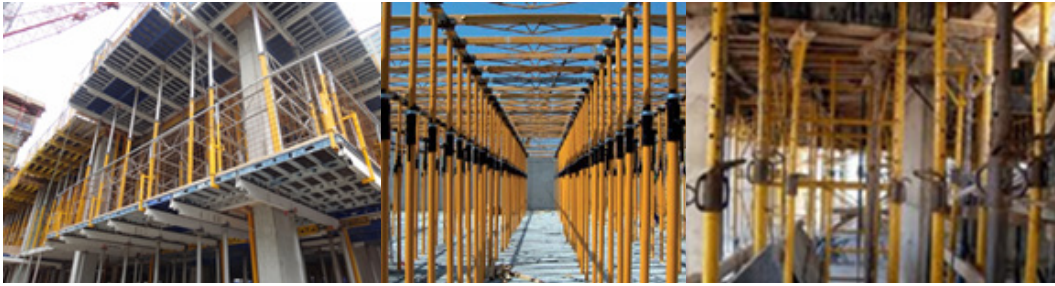
Figura 160 - Escoramentos Metálicos para Fôrmas
