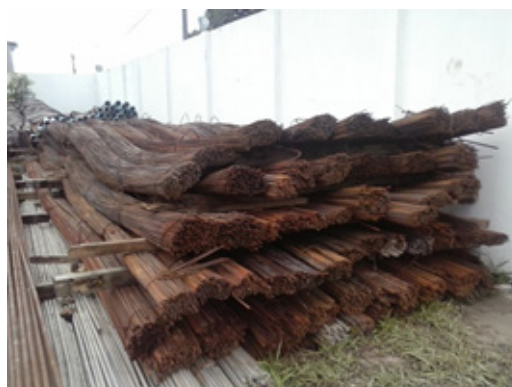
Figura 151 - Armazenamento de Vergalhões
