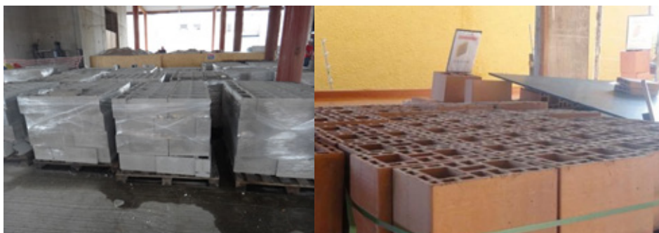
Figura 55 - Armazenamento de Blocos de Concreto Figura 56 - Armazenamento de Blocos Cerâmicos
