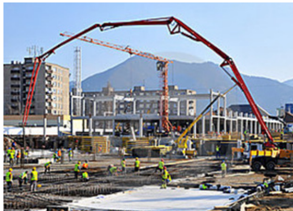
Figura 190 - Bombeamento de Concreto
