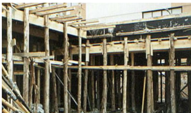
Figura 161 - Escoramento de Eucalipto
