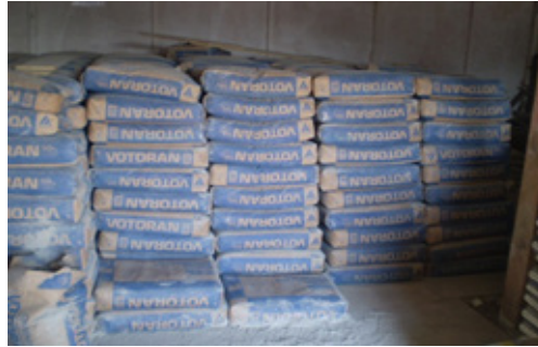
Figura 43 - Armazenamento de Cimento
