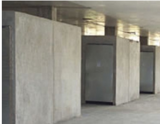
Figura 202 - Instalação de Banheiros Prontos
