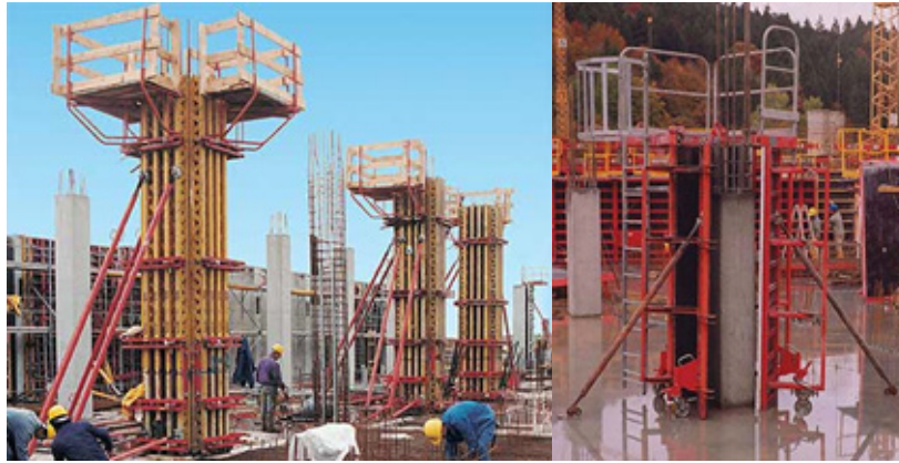
Figura 177 - Formas para Pilares
