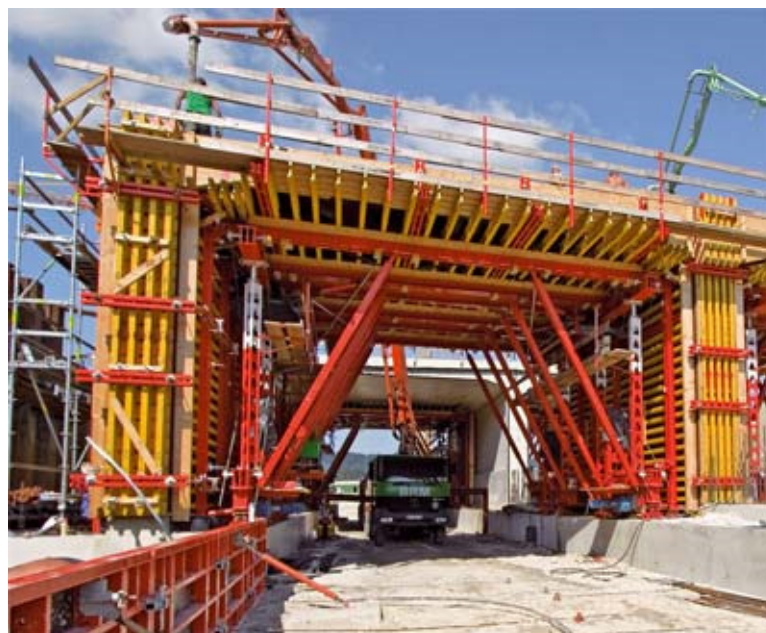
Figura 176 - Fôrma e Escoramentos para Pontes e Túneis
