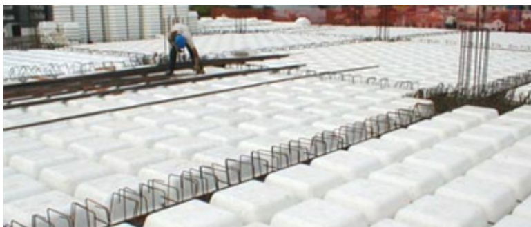
Figura 184 - Fôrmas Plásticas para Lajes Nervuradas (Cubetas)
