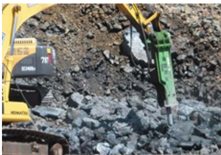
Figura 103 - Desmonte de Rocha Mecanizado
