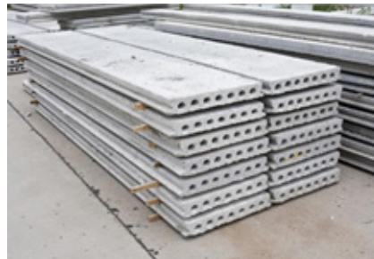
Figura 199 - Armazenamento de Lajes Pré-fabricadas
