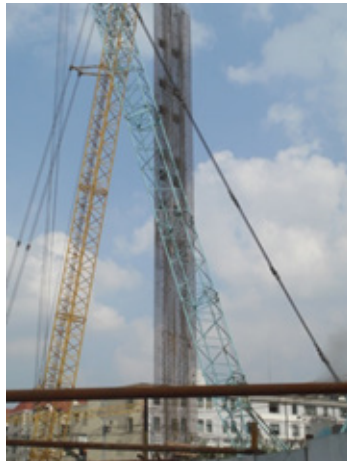
Figura 209 - Colocação de Armadura na Parede Diafragma
