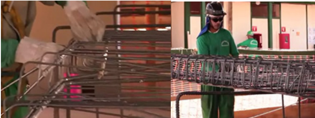
Figura 157 - Montagem de Armaduras
