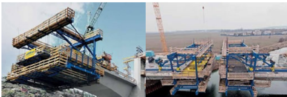
Figura 183 - Carro de Avanço (Combina Torre de Carga e Fôrma)
