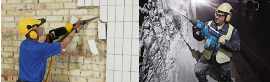
Figura 94 - Demolição com Martetele
