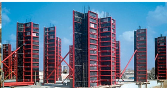
Figura 163 - Fôrma Modulada
