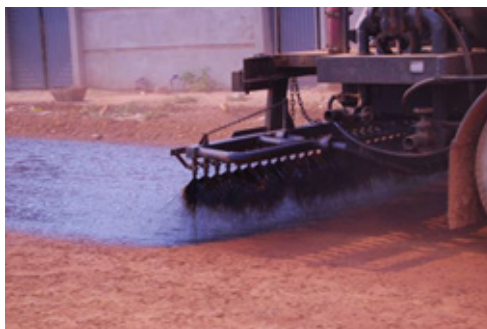
Figura 134 - Processo de Imprimação
