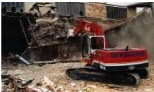
Figura 96 - Demolição por Impulso
