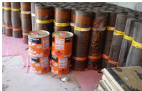
Figura 76 - Armazenamento de Manta Asfáltica
