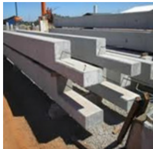
Figura 198 - Armazenamento de Pilares
