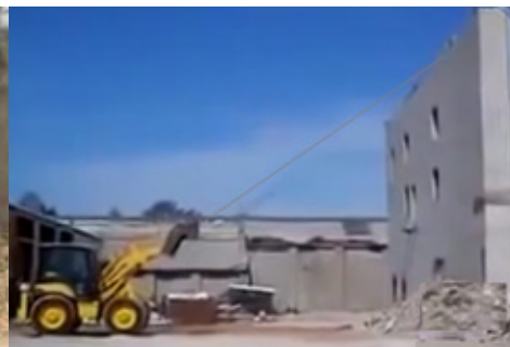
Figura 97 - Demolição por Tração
