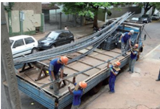
Figura 149 - Descarregamento Manual de Vergalhões
