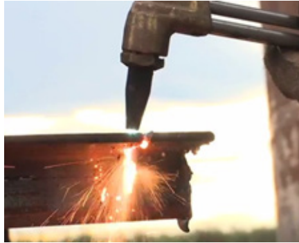
Figura 92 - Corte de Estruturas Metálicas a Quente
