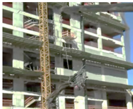
Figura 150 - Descarregamento Mecânico de Vergalhões
