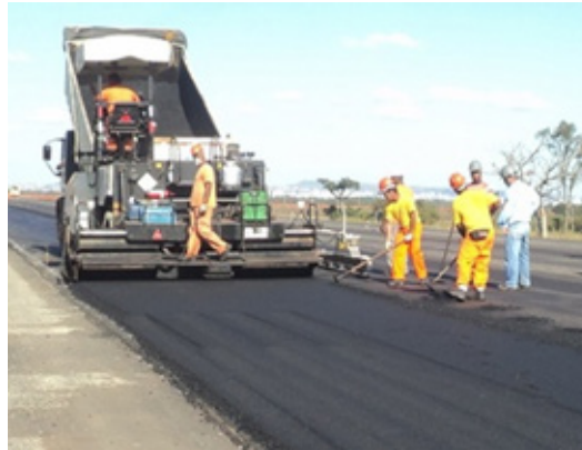
Figura 137 - Capa Asfáltica
