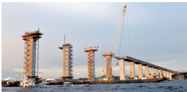
Figura 213 - Construção de Ponte
