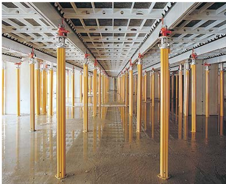
Figura 179 - Fôrmas para Lajes
