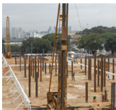
Figura 115 - Bate-estacas (Perfil Metálico)
