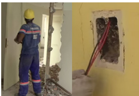
Figura 88 - Retirada de Elementos frágeis
