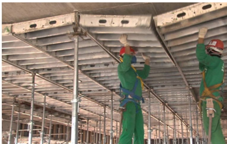
Figura 194 - Serviços de Desforma de Concreto
