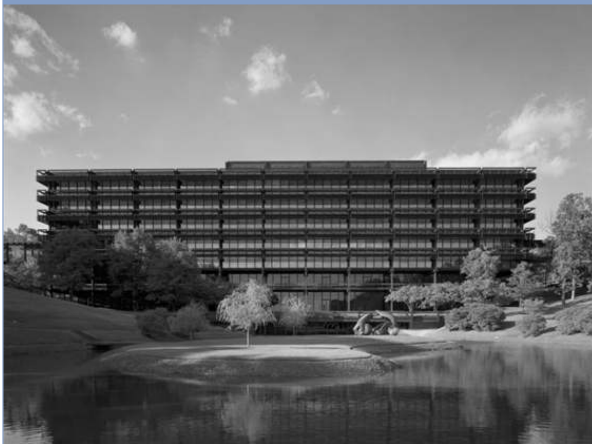
Figura 14: O edifício-sede da Deere & Company, feito em aço patinável.
