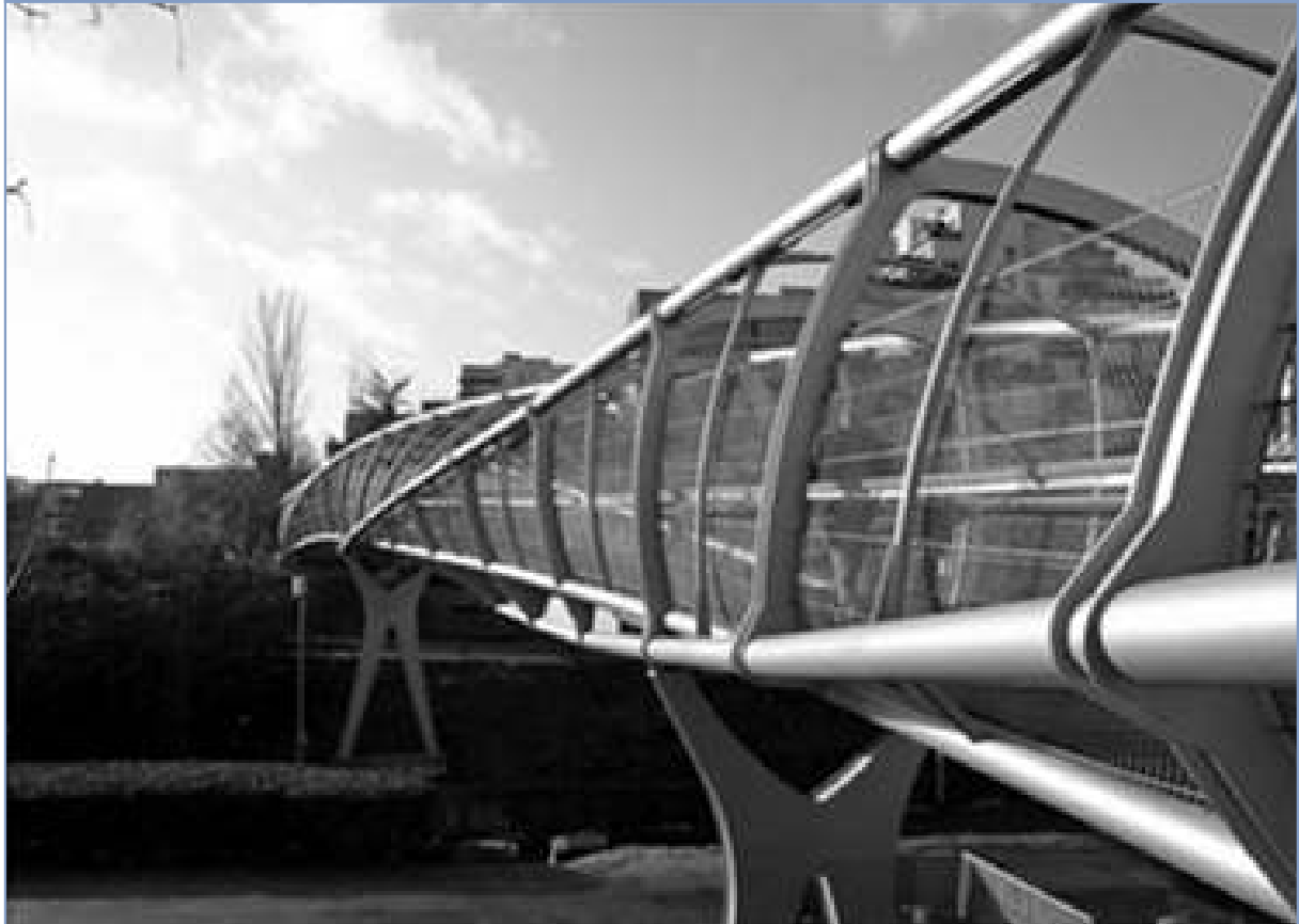
Figura 23: Tubos devem ser impermeáveis ao ar e à umidade. Passarela de pedestres em Évry, França.
