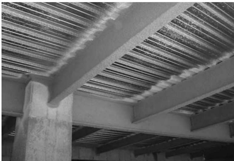
Figura 53: Vigas protegidas por argamassa projetada.
