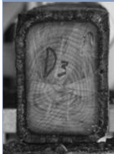
Figura 41 - Carbonização de pilar de madeira.
