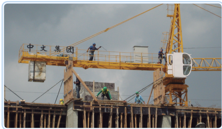
Figura 19.1: Trabalho executado com grua
