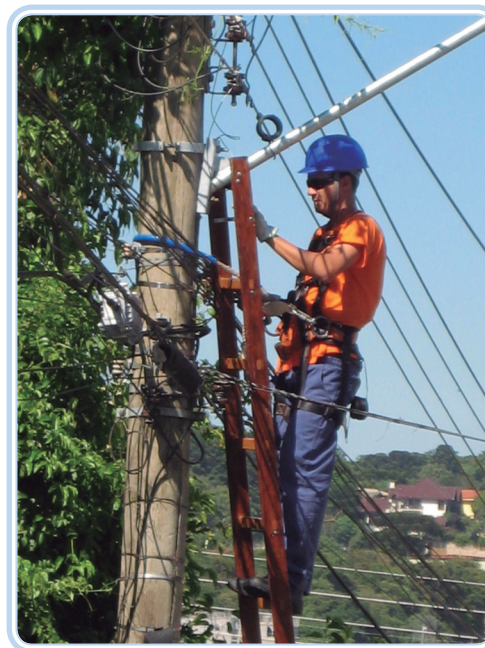
Figura 20.3: Trabalhador com cinto de segurança e sistema de ancoragem
